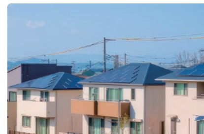
太陽光パネル
